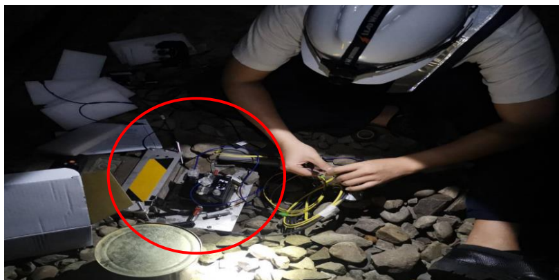
差異沉陷計安裝
