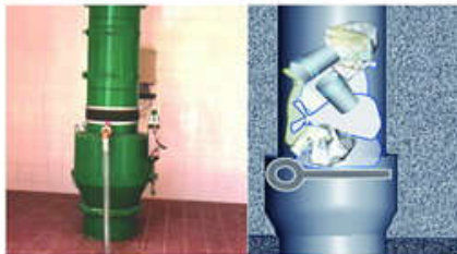
⑥ 暂存垃圾槽- 排放阀室,用户投入的垃圾将会暂时存放在这个封闭的容器内,由远程计算机控制进行垃圾的清空,每个排放阀的清空过程约为30秒。
