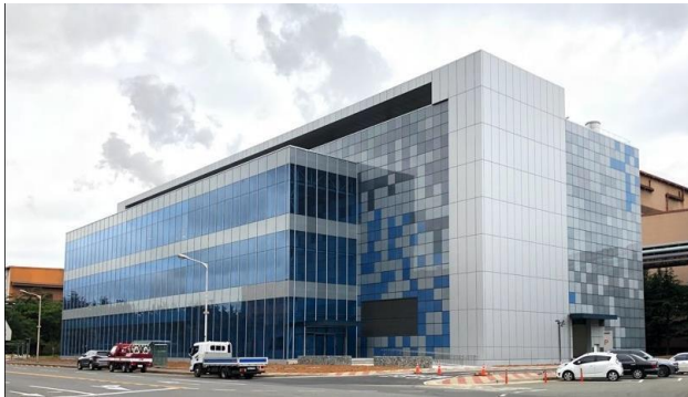
◎ POSCO 数据中心 (浦项钢铁厂) 140kW (2018年)
