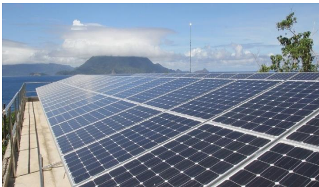
◎ 菲律宾 30kW Solar+180kWh ESS+15kW Diesel (2016年)
