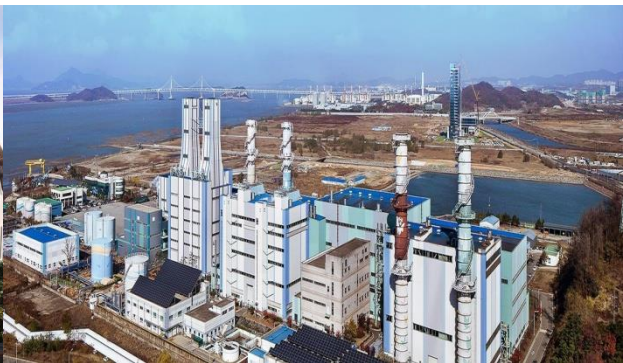
◎ 仁川综合火力总部 2019年 正在安装
