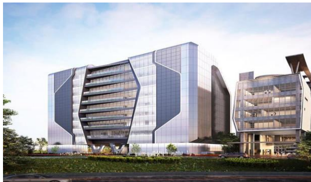
◎ YG大楼 2019年 正在安装
